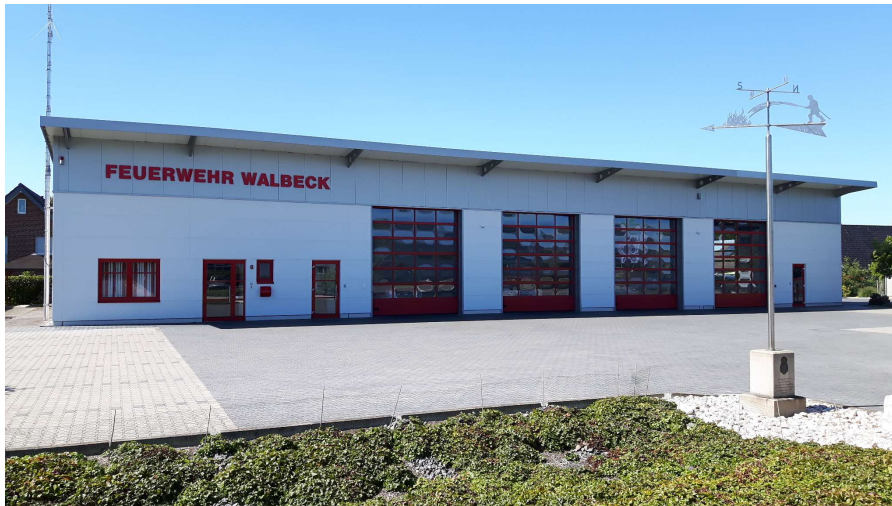
Feuerwehrgerätehaus in Walbeck
